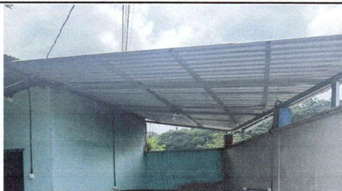
Foto 2: Remodelacion de techo por malas condiciones.
