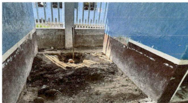
Foto 3: Inicio de controccion de tanque de agua para
