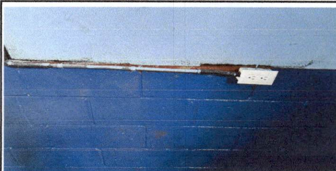
Foto 5: ejecucion de pintura de muros de interiores y exteriores.
