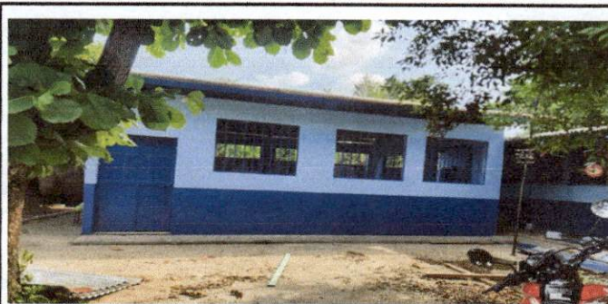
Foto 6: Pintura de muros de Interioeres y exterioeres
