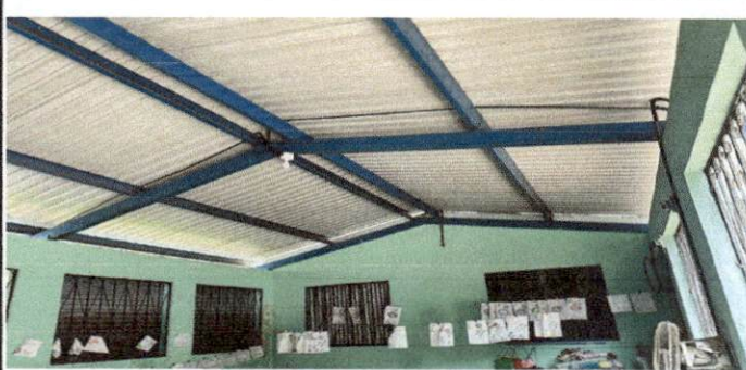
Foto 4: inicio de reparacion de sistema electrico
